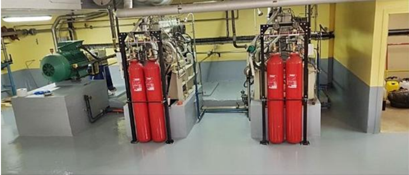
Le groupe de pompage du bassin de rétention
