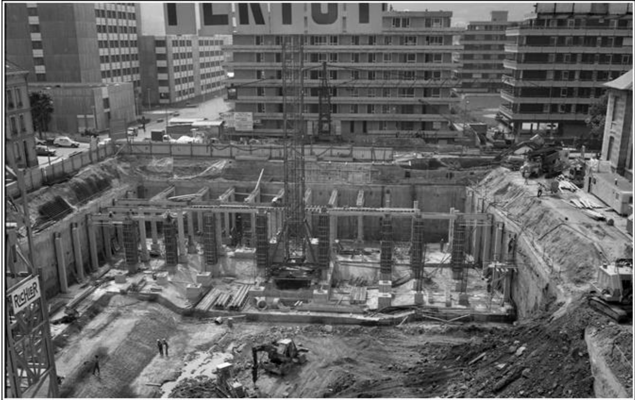
Le chantier en cours
