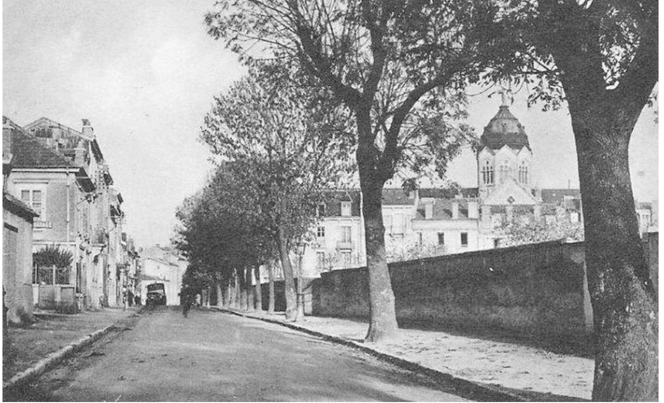
Rue de Laxou, le mur du domaine des Sœurs de Saint-Charles
