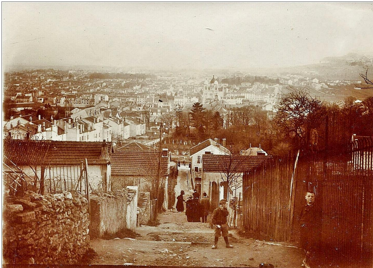
1908, la vue depuis l'escalier de la Cure d'Air
