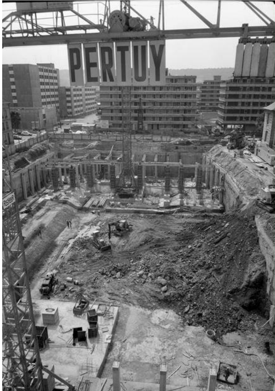
Le chantier en cours
