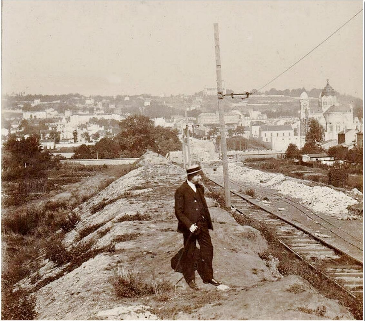
Le remblai de l'enclos de Médreville en 1907, avec la Cure d'Air dans le fond La voie ferrée transportait des wagonnets pour apporter la terre du remblai
