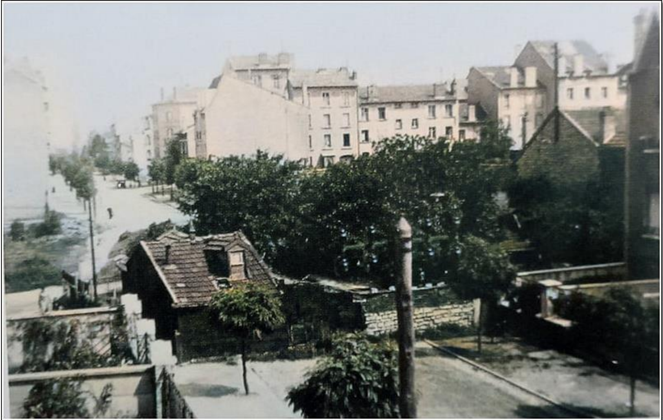
Les immeubles du boulevard Charlemagne à Nancy et la rue Raymond Poincaré à Laxou avant le percement de la rue Voltaire
