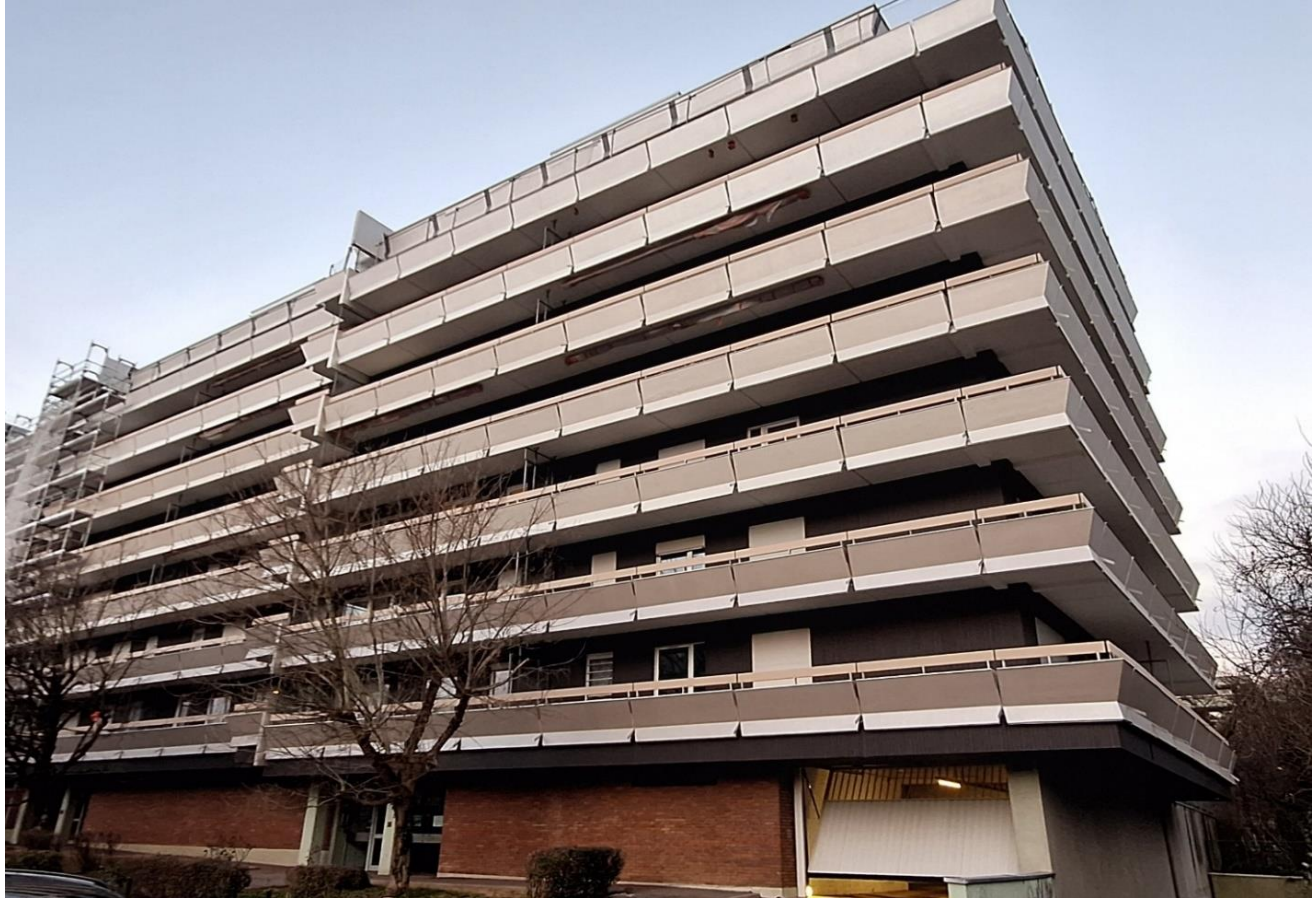
Le Clos sous son nouvel aspect rénové avec son dégradé de teintes s'éclaircissant du bas vers le haut (réfection pour la première des cinq phases – janvier 2025)
