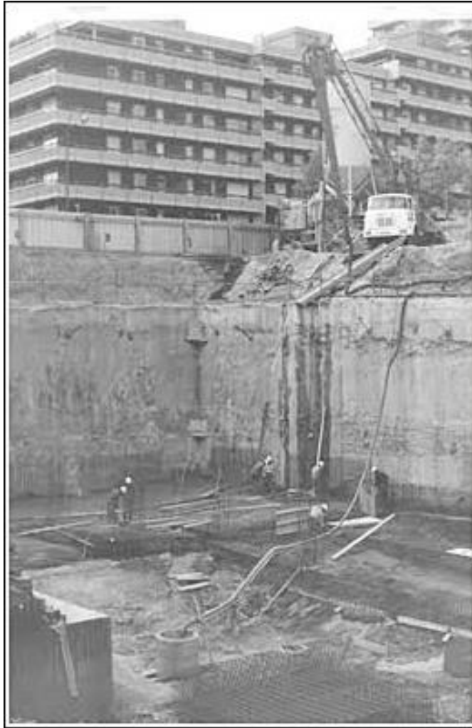
1974 - construction d'un réservoir et d'un parking (95 places) sous la place des Ducs de Bar
