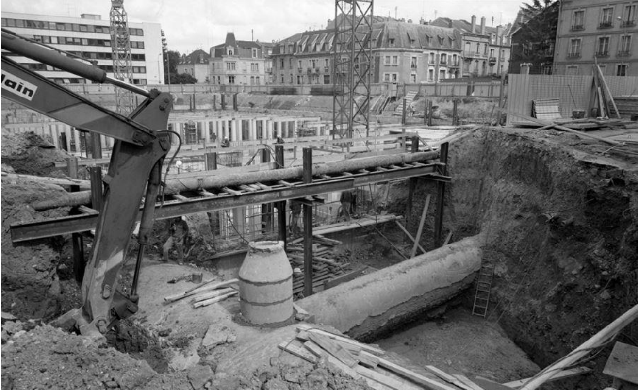
Le chantier en cours
