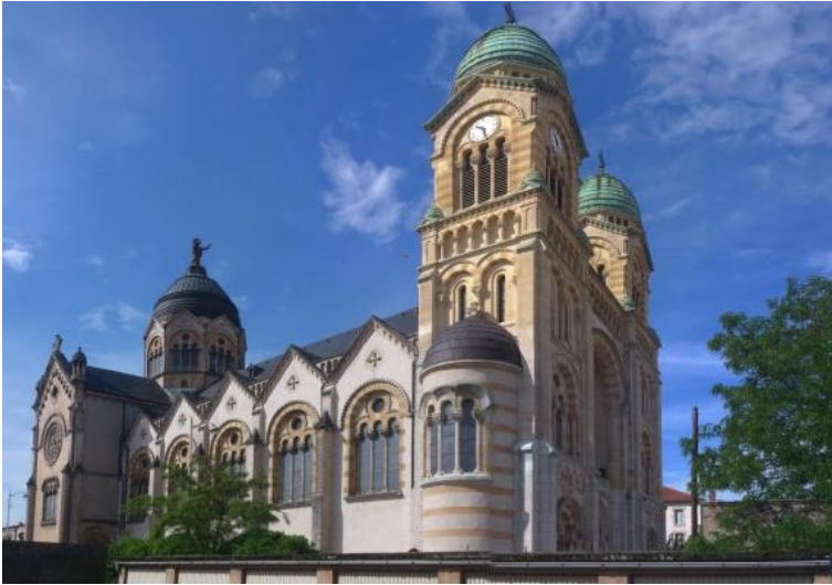
Les tours de la façade hautes de 55 m.
